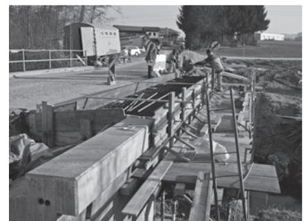
Die Fahrbahn wird auf insgesamt 6 m verbreitert. Zusätzlich entsteht ein Gehsteig mit 1,5 m
