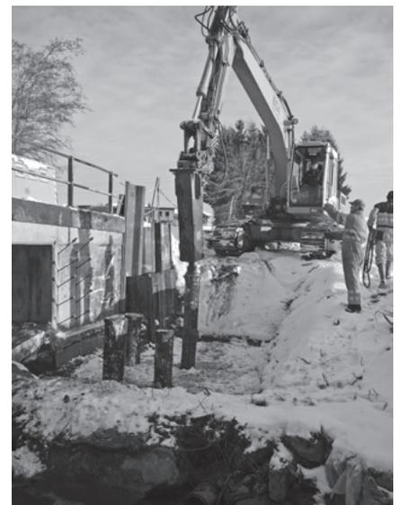
Zur Fundamentierung der Brückenerweiterung wurden Piloten geschlagen
