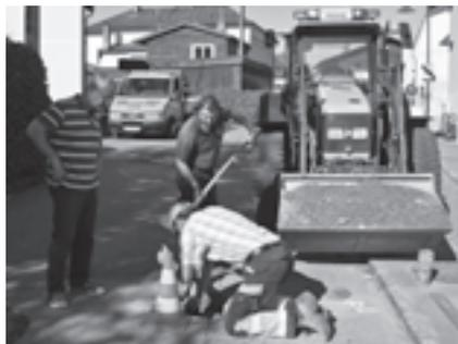
*Vor der Asphaltierung mussten sämtliche Einbauten durch den Bauhof an die neuen Höhen angepasst werden*
