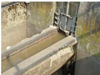
Der Beton des Zulaufgerinnes wurde durch das Abwasser teilweise zersetzt und muss nun fachgerecht saniert werden
