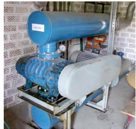
Dieses Gebläse zur Belüftung des Belebungsbeckens hat nach 35 Jahren ausgedient und wird durch ein modernes und energieeffizientes Gerät ersetzt
