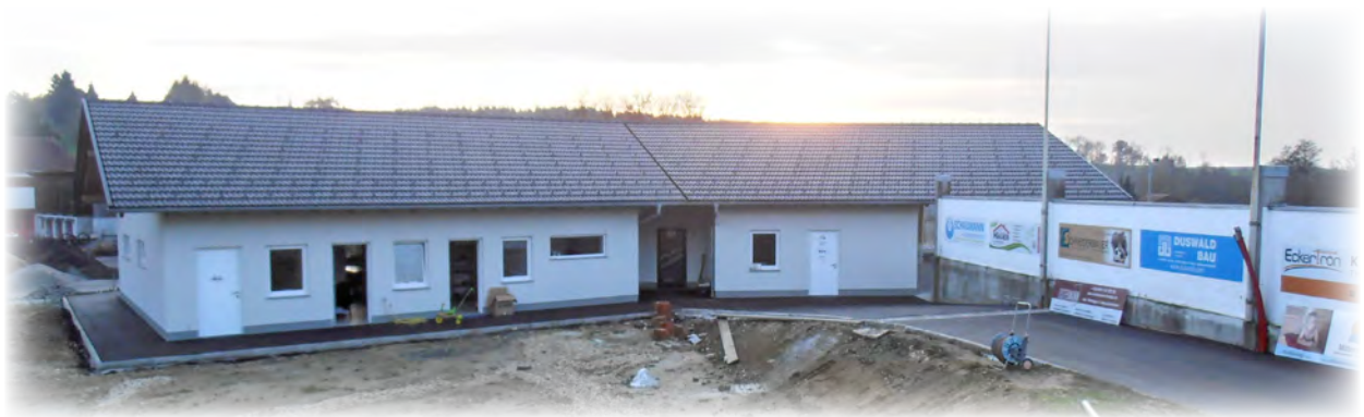
Die Arbeiten am Sportzentrum gehen voran. Die Fertigstellung der Außenanlage mit Tribünenüberdachung wird im Frühjahr erfolgen. Von der Union Sektion Fußball wurden bereits ca. 4000 freiwillige Arbeitsstunden geleistet.
