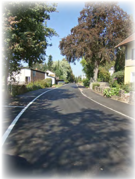
Die Schulstraße wurde im Sommer umfassend saniert: Neuverkabelung der Straßenbeleuchtung, barrierefreie Gehsteige, neuer Belag
