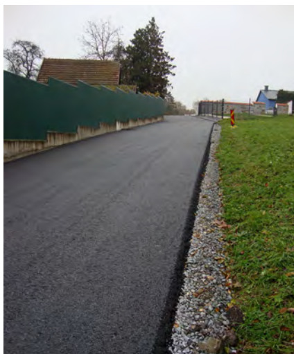
Die neu asphaltierte Straße zum Urnenhain
