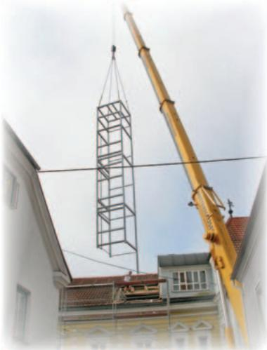
Das Einbringen der Stahlkonstruktion für den Liftschacht in der Musikschule
