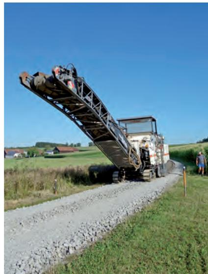
Durchfräsung des Güterwegs Krennhof zur Verstärkung des Tragkörpers
